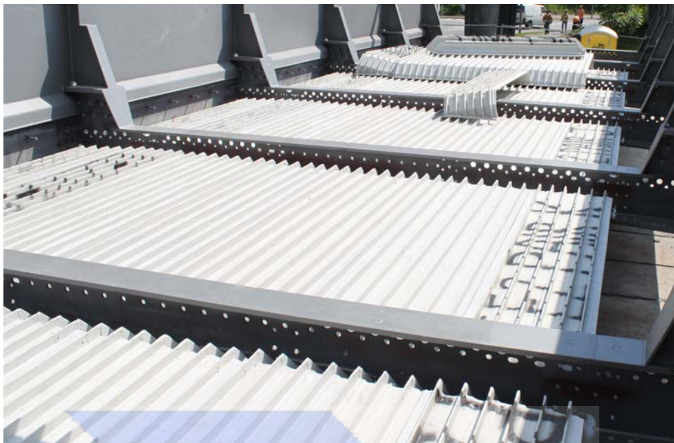
Obr. 15 - Příklad použití kompozitních vyztužených desek pro ztracené bednění desky mostovky
