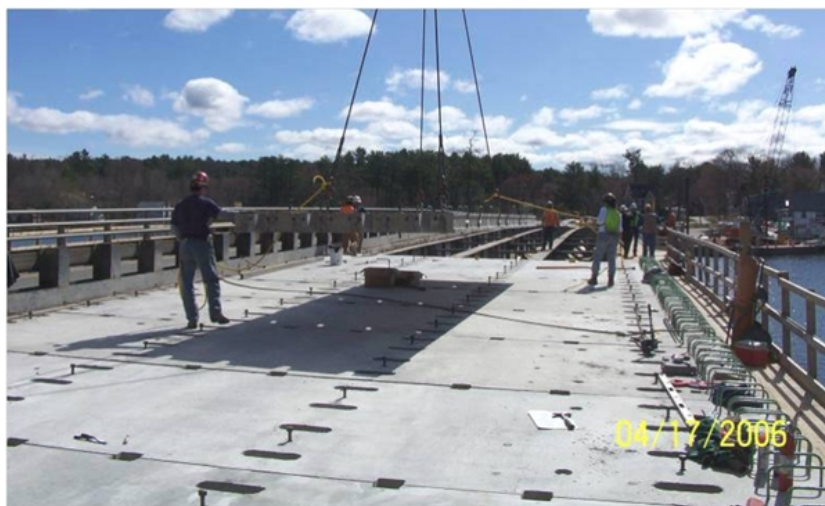
Obr. 17 - Příklad použití prefabrikované spřažené desky
